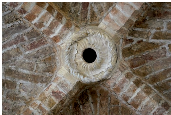
fig. 24 Fabriano, San Venanzio, cappella di San Giovanni Battista. Chiave della volta a crociera settentrionale (foto F. Coden).
