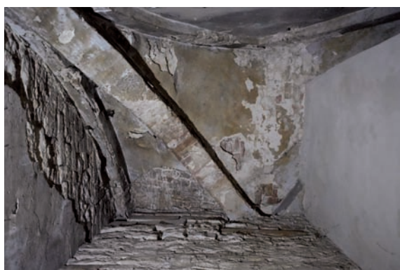
fig. 25 Fabriano, San Venanzio, galleria. Volta dell'ambiente soprastante alla cappella di San Giovanni Evangelista (9/11) (foto F. Coden).
