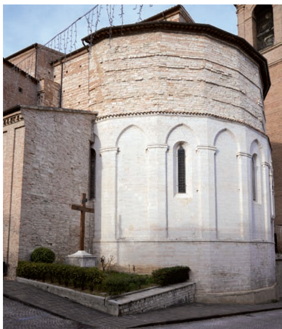
fig. 7 Fabriano, San Venanzio, esterno est. La tribuna vista da sud-est (foto F. Coden).
