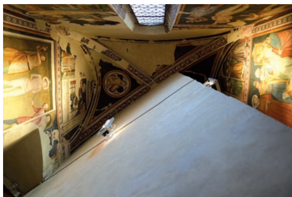
fig. 16 Fabriano, San Venanzio, cappella di San Lorenzo. Volta a crociera con parte dei perimetrali del coro seicentesco (foto F. Coden).
