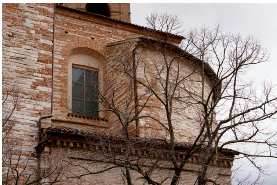
fig. 19 Fabriano, San Venanzio, esterno sud. Particolare delle murature a livello della galleria della tribuna, nel punto in cui si trovava il primo ambiente (1/11) della galleria (foto F. Coden).
