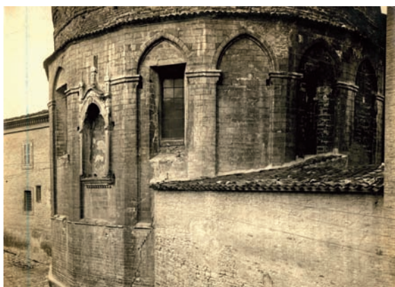
fig. 36 Fabriano, San Venanzio, esterno sud. Veduta della tribuna e del corpo di fabbrica pertinente alla Confraternita del Santissimo Sacramento prima della demolizione (Fabriano, Biblioteca comunale, fondo Bocci, 52484, n. 297 fotografie, fasc. 1-43).
