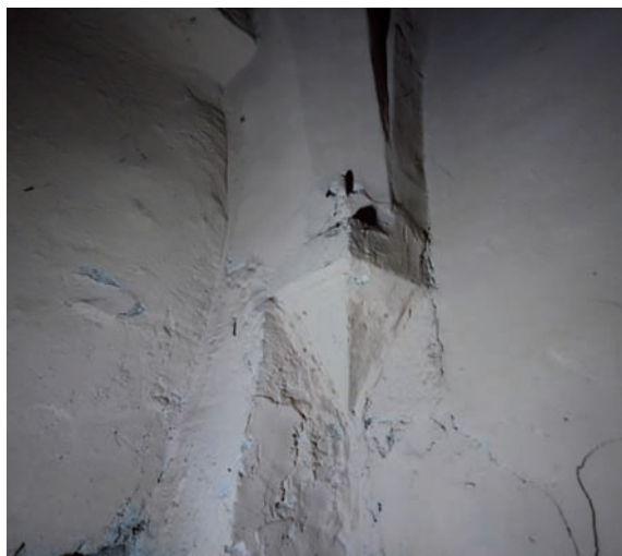
fig. 15 Fabriano, San Venanzio, cappella della Santa Croce. Imposta della volta a crociera (foto F. Coden).
